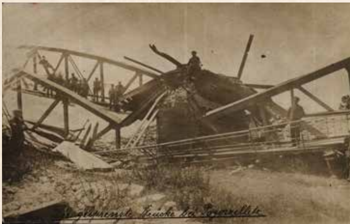
Most drogowy na Kłodnicy pod Pogorzelcem (obecnie dzielnica Kędzierzyna) wysadzony przez wycofujących się powstańców, 4 czerwca 1921 r.
