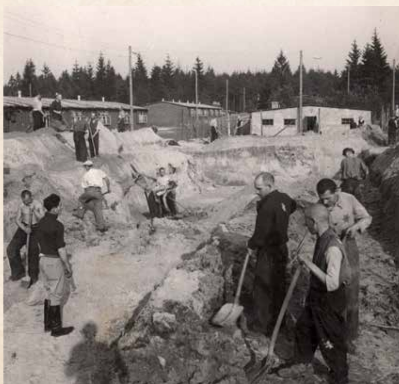
Więźniowie pracujący przy budowie magazynu na ziemniaki
