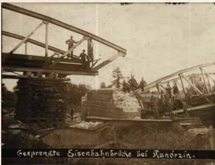
Most kolejowy koło Kędzierzyna zniszczony przez powstańców
